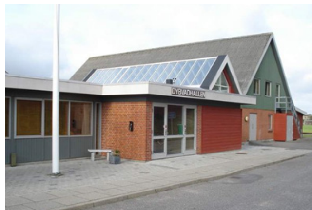
Klubhus og nyere mellembygning
